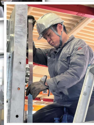
▲大型設備の組立作業
